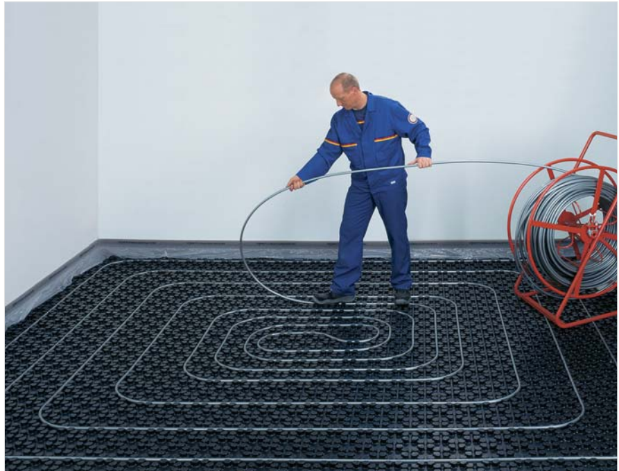
Bild 11: Verlegung eines Fußboden-Heiz-/Kühlsystems
