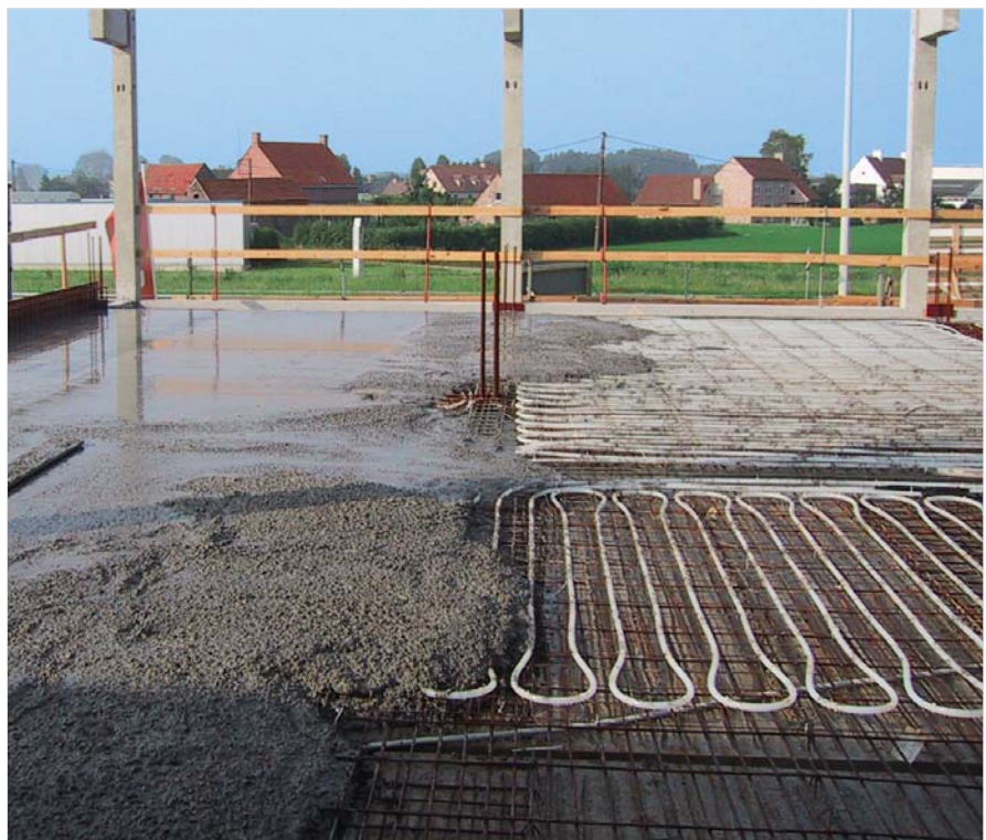
Bild 12: Bauteilaktivierung/Betonkernaktivierung – Erstellung der Zwischendecke mit Rohrsystem
